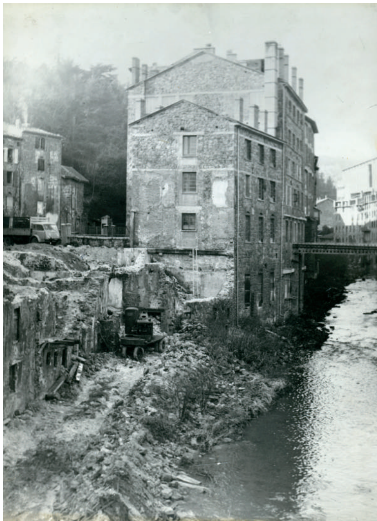
Démolition d'une ancienne mégisserie rue Franc, années 1960. La passerelle qui traverse la rivière relie les bâtiments de l'usine de chaussures Duchier
