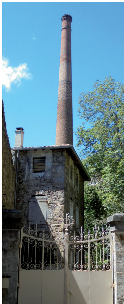
Une des deux dernières cheminées en briques à Annonay, ancienne mégisserie des Falcons
