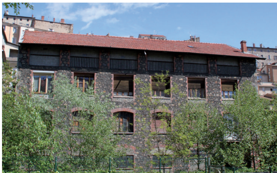
Vue des locaux abandonnés de l'ancienne tannerie Franc (fermée en 1954), quartier de Cance
