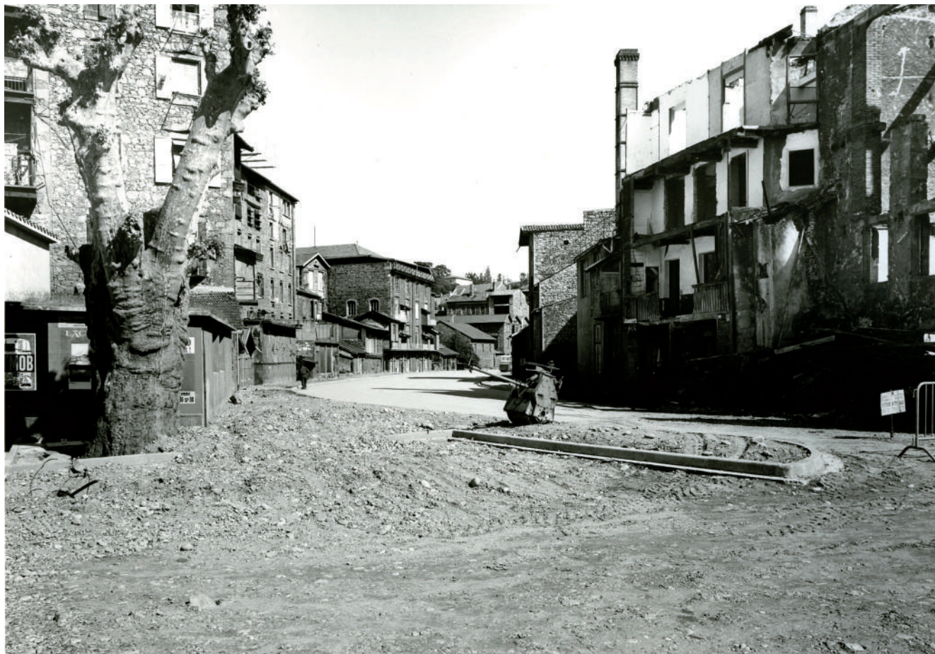
Vue de la future avenue de l'Europe couvrant la Deûme. Cette vue est prise de l'actuel rond-point de Faya. On remarque au centre en arrière plan les bâtiments de la Concentration Mégisseries d'Annonay. Aujourd'hui seul le platane au premier plan à gauche permet de se repérer, tous les autres bâtiments ayant été démolis
