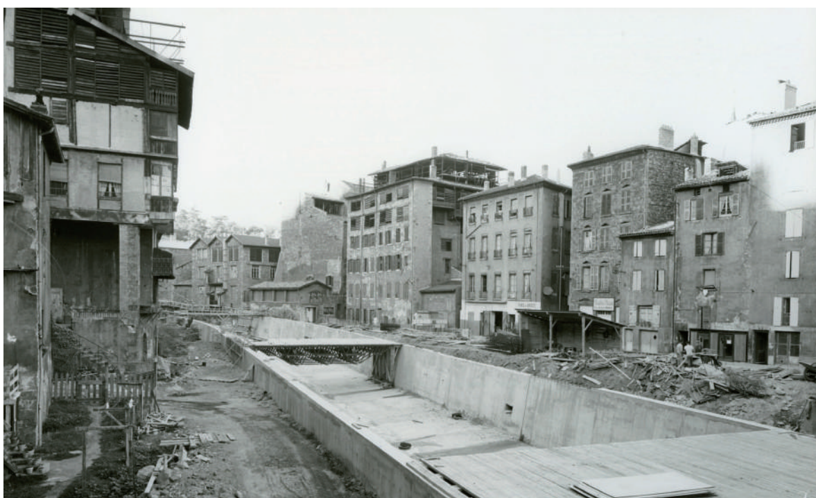
Début des travaux de couverture de la Deûme avec de part et d'autre de la rivière d'anciennes mégisseries reconnaissables à leur séchoirs en bois
